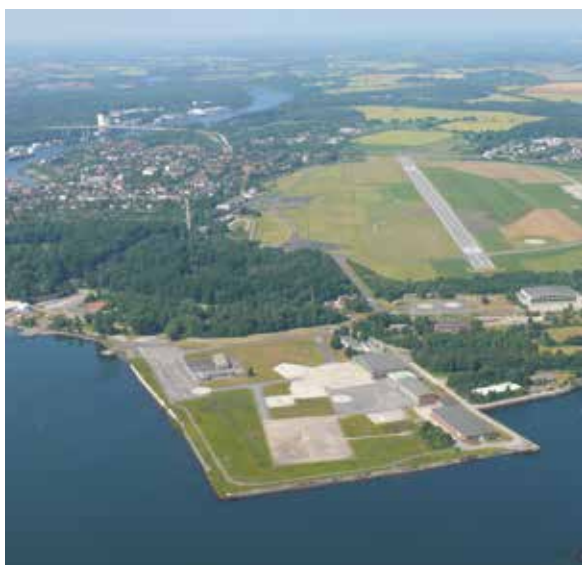
Auf dem Gelände des ehemaligen Marinefliegergeschwaders 5 in Kiel soll in Zukunft ein neuer Stadtteil entstehen.
