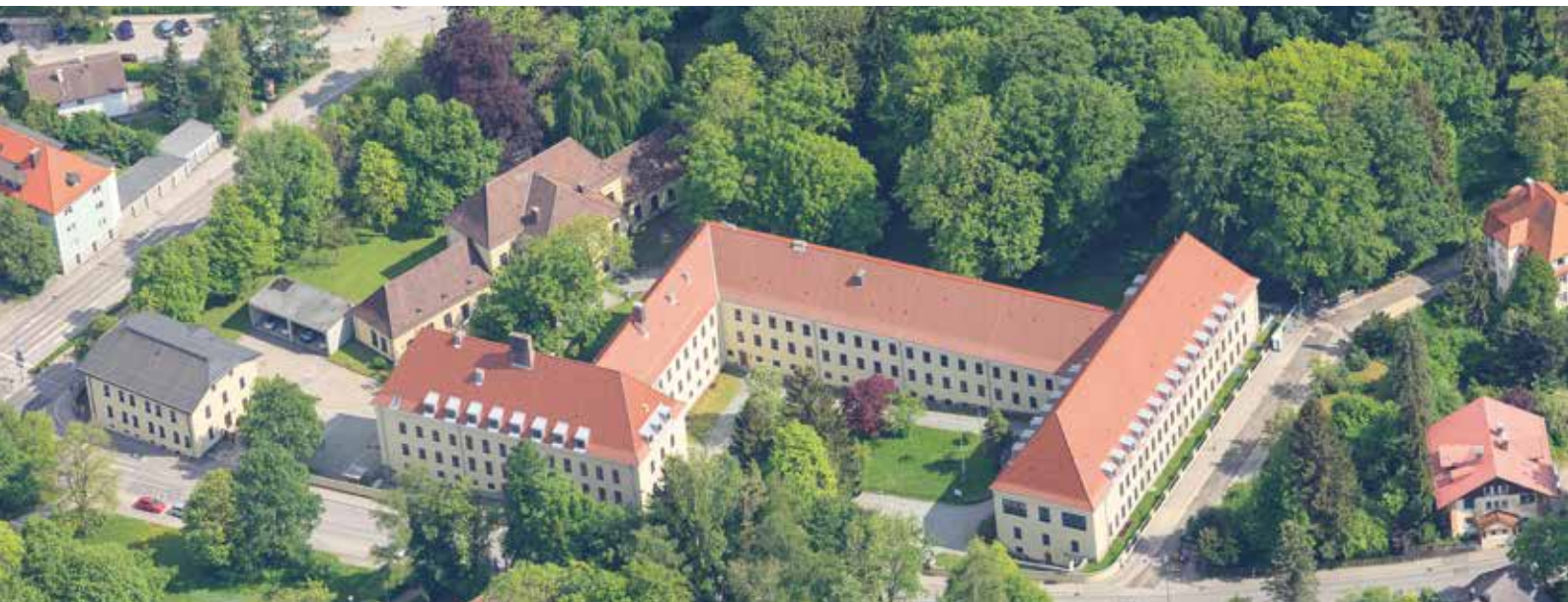
Das ehemalige Fachsanitätszentrum der Bundeswehr in Kempten veräußerte die BImA Ende 2016.
