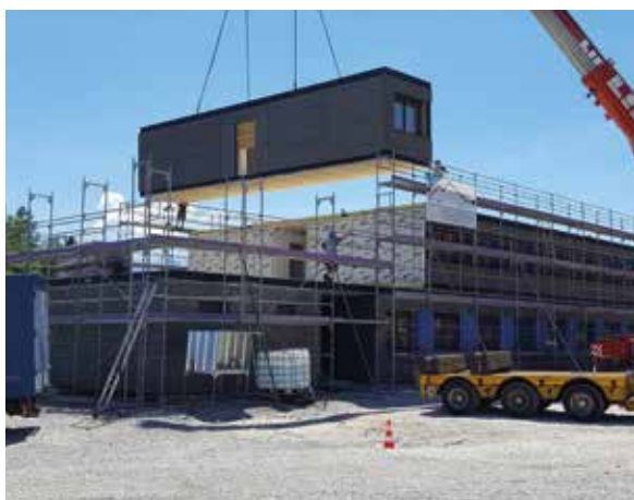
Mit modularer Bauweise reagiert die BImA auf den schnell wachsenden Platzbedarf der Bundespolizei.
