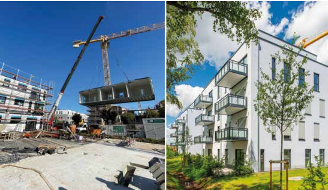
Modul für Modul zu neuen Wohnungen: In Aschaffenburg setzt die BImA auf eine ressourcensparende serielle Bauweise.
