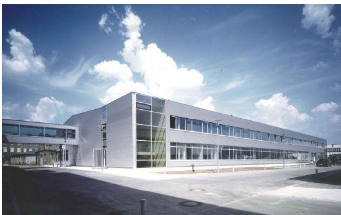
Neues Endfertigungsgebäude kurz nach der Fertigstellung (1995)
