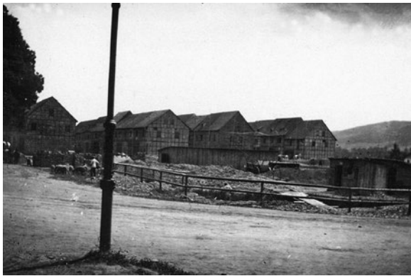
Fabrikgrundstück in Rudolstadt-Cumbach vor Baubeginn (Juli 1922)
