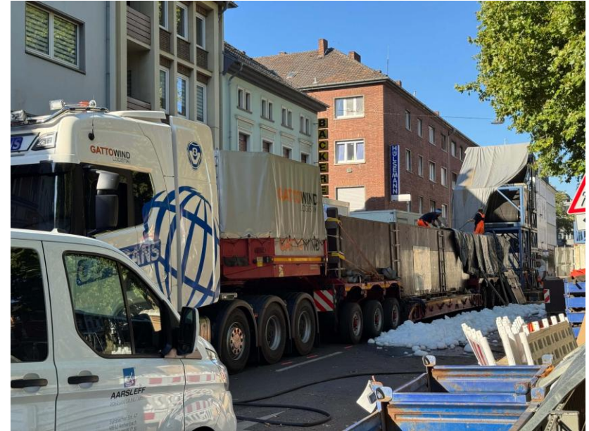
Anlieferung des Inliners mit einem Tieflader
