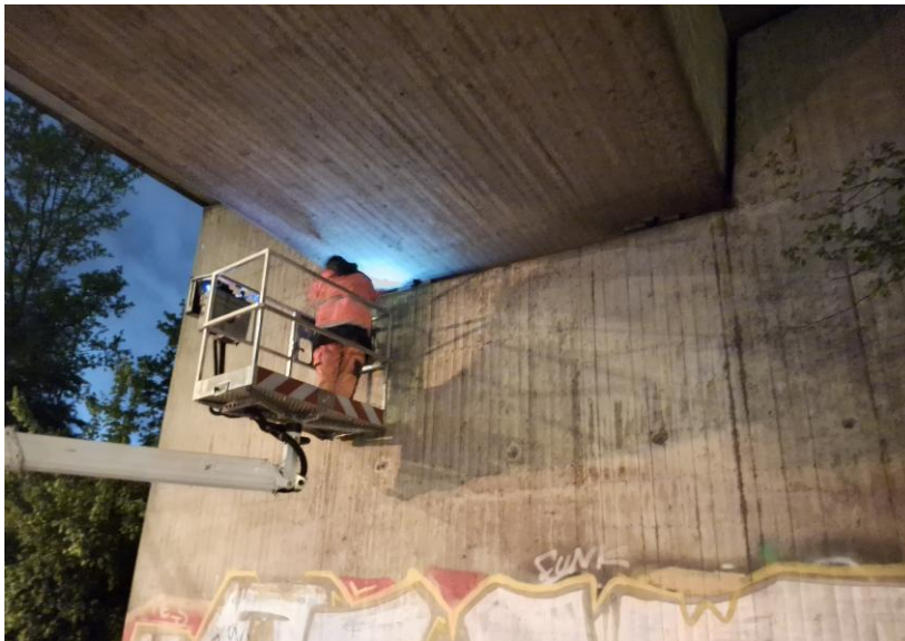
Nächtliche Bauwerksprüfung der Brücke Untergath
