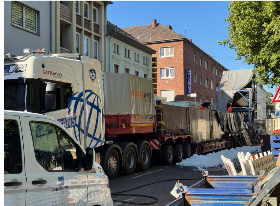
Anlieferung des Inliners mit einem Tieflader
