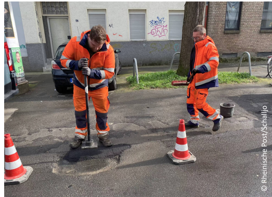
Reparaturteams des KBK beheben die Schäden
