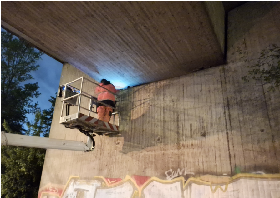
Nächtliche Bauwerksprüfung der Brücke Untergath
