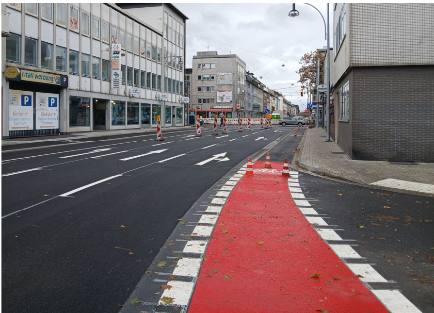
Fertig gebaut: 1. Bauabschnitt Philadelphiastraße
