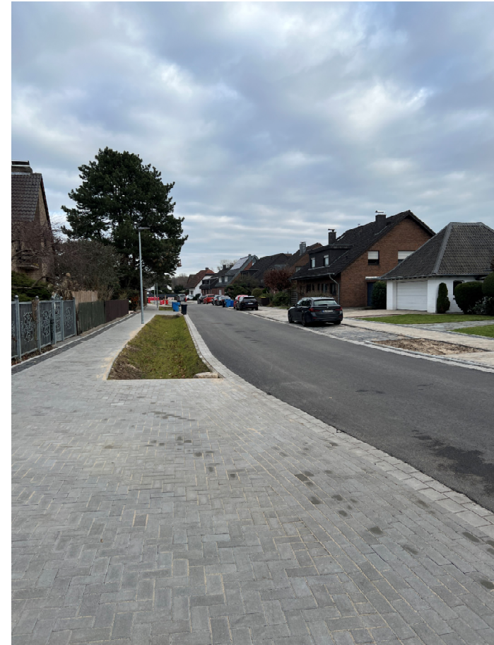
Ausbau der Straße „Am Schroersdyk“
