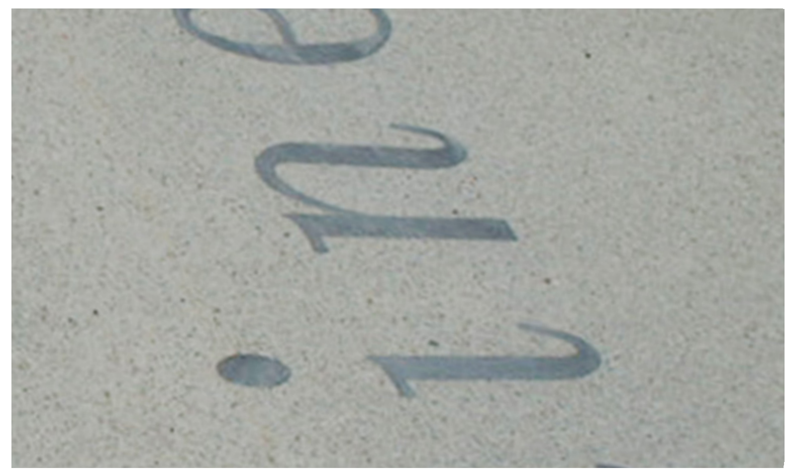
Bodenintarsie aus Aluminium im geschliffenen Estrich
