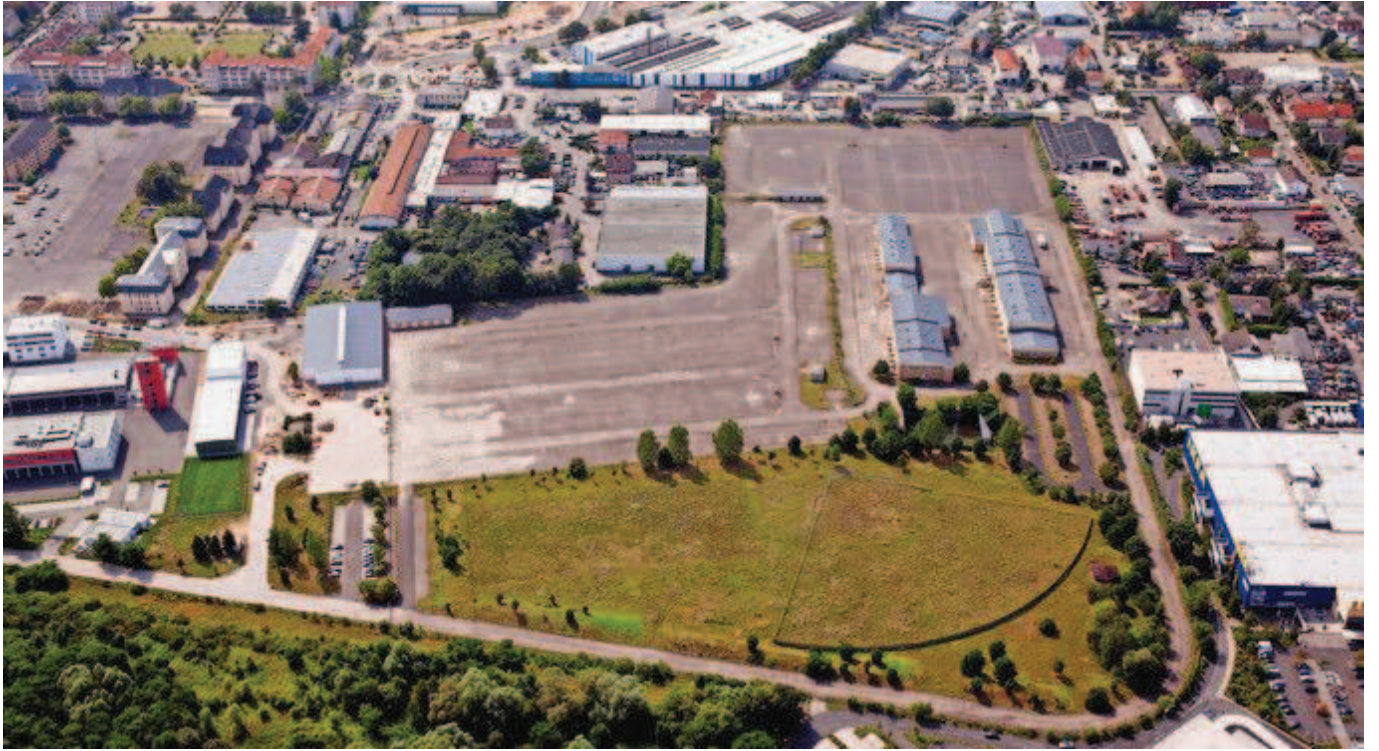
Hier entsteht das Gewerbegebiet »Am Lamboywald«. Foto: Stadt Hanau
