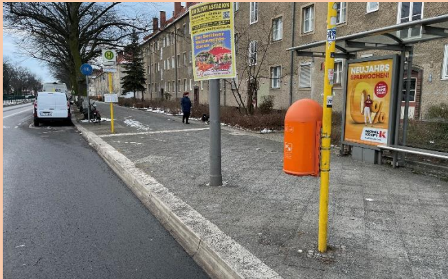
Barrierefrei ausgebaut Haltestelle (GP, 2025)
