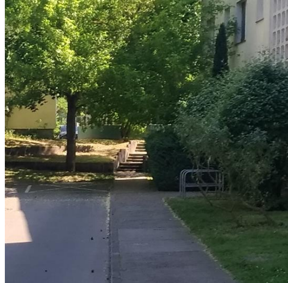
Abb. 8: Treppe ohne Handlauf und Rampe (GP, 2024b)
