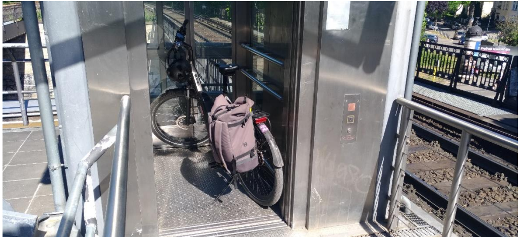
Abb. 15: Fahrstuhlkabinentür am Mexikoplatz durch Hinterrad blockiert (GP, 2024b)
