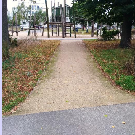
Wasserdurchlässig befestigter Weg (GP, 2024b)
