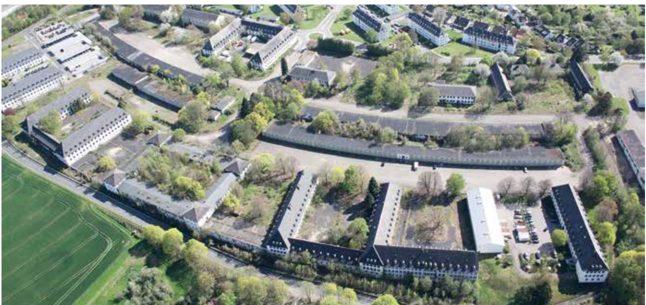
Foto: Luftbildaufnahme (Fritsch-Kaserne)
