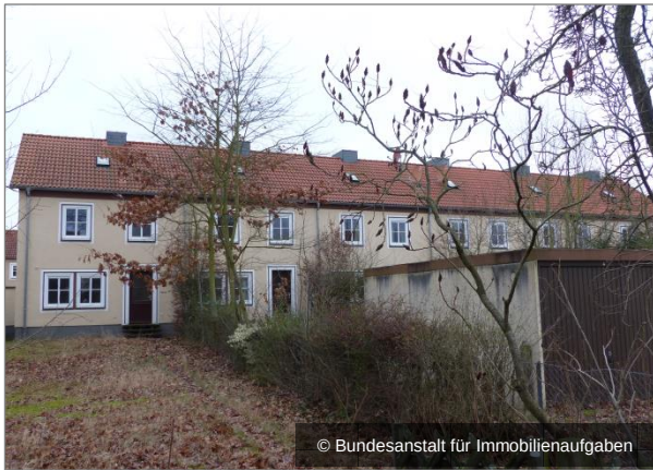
Rückfronten Haus Nr. 13 – 7
