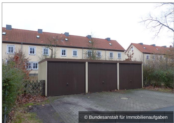
Garagenblock hinter Haus Nr. 15 - 25
