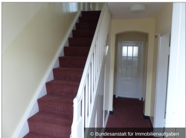
Treppe EG zum OG exemplarisch
