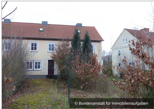
Rückfronten Haus Nr. 3 + 5
