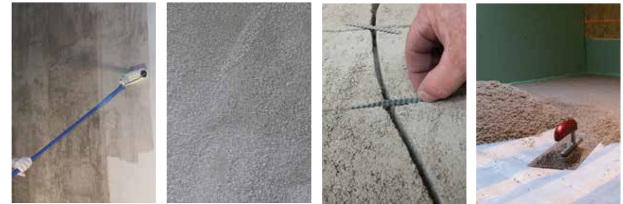
Grundierung Haftbrücke, Sandeinstreuung in frischem Zustand Rissverschluss Bindemittel für Estriche und Drainagemörtel
