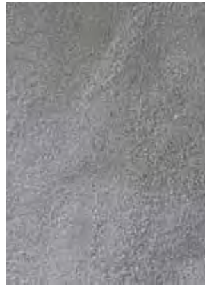
Haftbrücke, Sandeinstreuung in frischem Zustand
