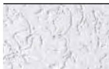
Reibeputz (Rillenputzstruktur)
