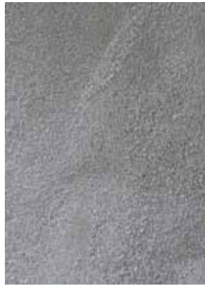
Haftbrücke, Sandeinstreuung in frischem Zustand
