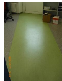
Flucht- und Rettungsweg Änderung des Bodenbelages
