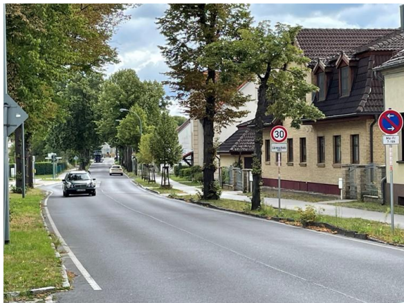
Abbildung 30: Chausseestraße in Deutsch Wusterhausen
