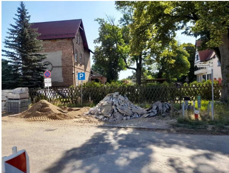
Abbildung 36: Baustelle Kablow Bahnhofsstraße
