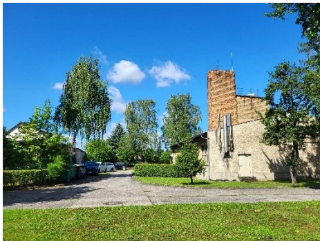
Abb. 8: Wendekreis mit Stellplätzen und Heizhaus
