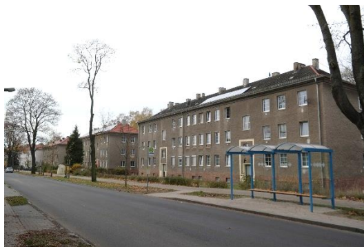
Abb. 22: Geschosswohnungsbau entlang der Karl-Marx-Straße
