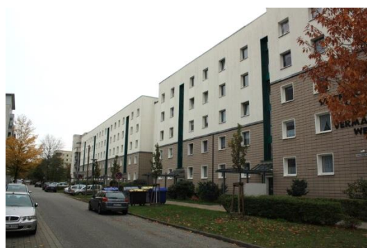
Abb. 17: Geschosswohnungsbau innerhalb des Neubaugebietes
