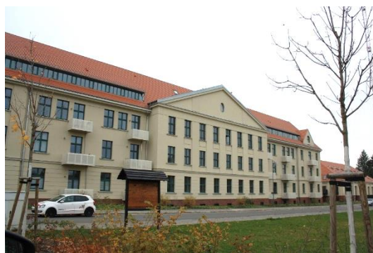
Abb. 16: Ehemaliges Kasernengebäude auf dem Funckerberg
