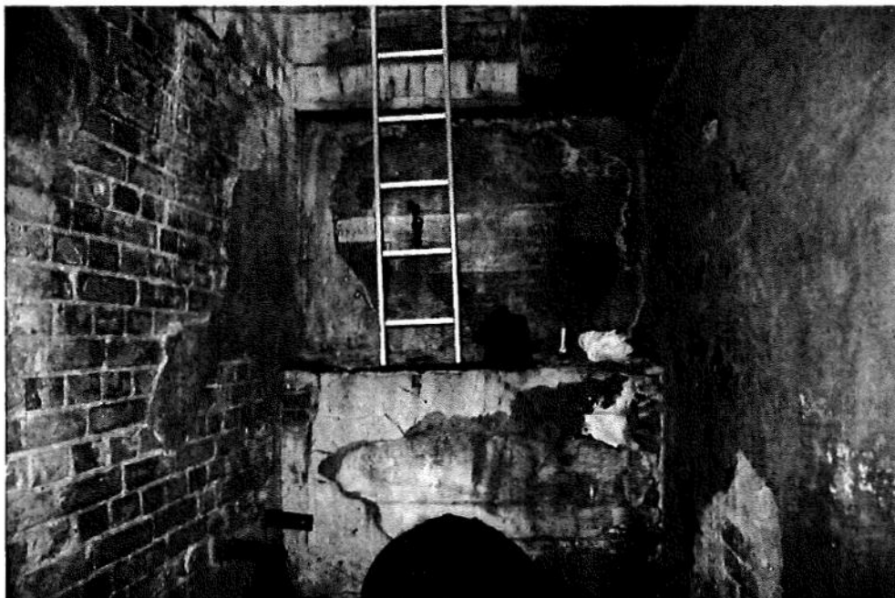
Abb. 3: Zugangsschacht zu Rohrleitungen mit hohem Potenzial als Fledermauswinterquartier
