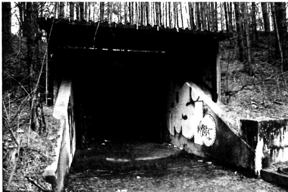
Abb. 5: Eingangsbereich zum Winterquartier der Zwergfledermäuse
