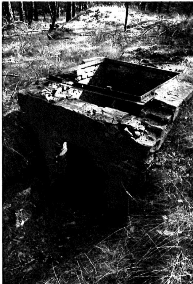
Abb. 1: Reste von vermutlich Wartungsschächten im Untersuchungsgebiet
