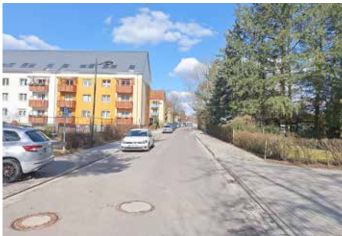
Der erste Bauabschnitt der Fontanestraße ist fertiggestellt.
