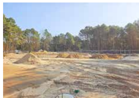
Auf der Baustelle für das neue Feuerwehrgerätehaus laufen die Arbeiten nach der Winterpause wieder an.
