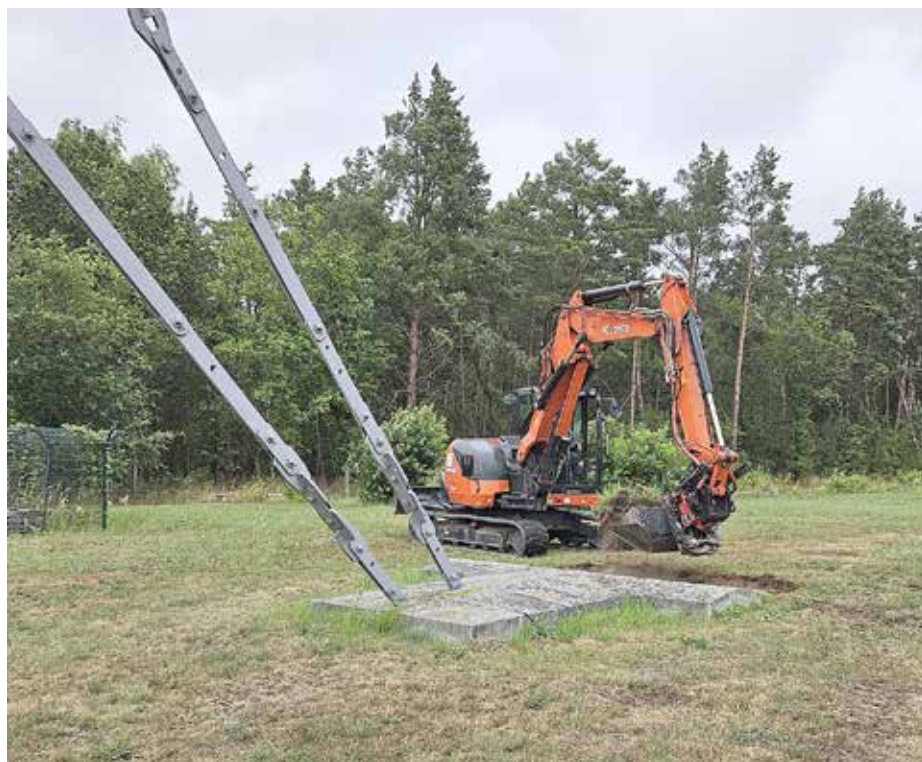
Die Baubilder zeigen die alten Fundamente. Sie bleiben erhalten, dahinter sollen dann die neuen Fundamente gegossen werden. Foto: Stadt Königs Wusterhausen
