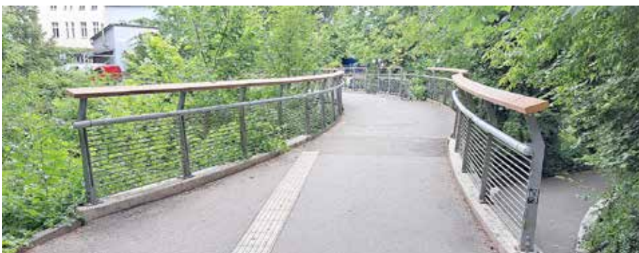
Im Juni 2026 wurde der neue Handlauf auf der Brücke zur Mühleninsel montiert.
