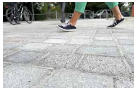
Auf einem kleinen Abschnitt ist das neue Granitsteinpflaster bereits begehbar.
