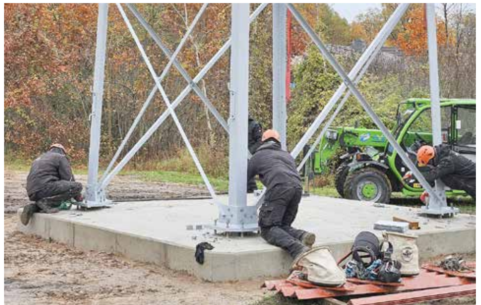
Der sanierte Konterturm wird fest mit dem komplett erneuerten Fundament verschraubt. Foto: Stadt Königs Wusterhausen
