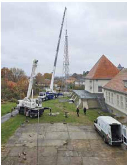
Große Kräne waren nötig, um den rund 30 Meter hohen Konterturm wieder aufzustellen. Foto: Stadt Königs Wusterhausen
