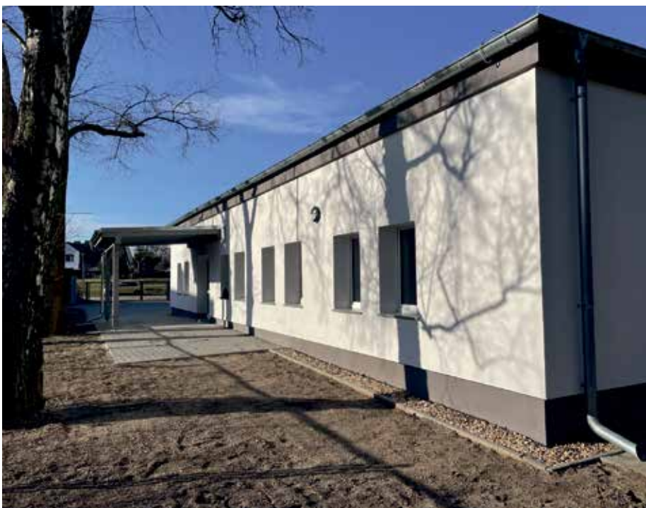
Das Mehrzweckgebäude in Niederlehme ist 2022 umfangreich saniert worden.
