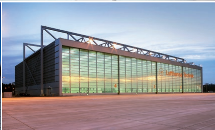
An der Frankfurter Lufthansa-Basis errichtete Lufthansa Technik einen neuen Hangar für die Überholung der A380-Flotten.
